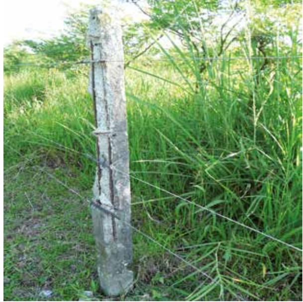
*Los postes de cemento son costosos y no son eternos. En la foto se observa poste de cemento construido con una buena estructura de hierro y pese a ello ya se ha deteriorado.*
